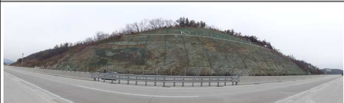
상주절토24 (관리이정 30.413~30.588km / 4공구 STA.1+430~1+605)
