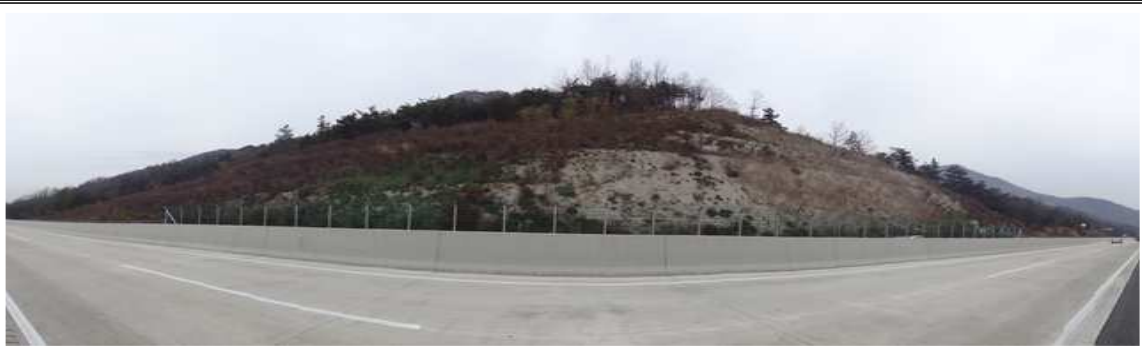
상주절토 15 (관리이정 18.104~18.334km / 3공구 STA.2+090~2+320)
