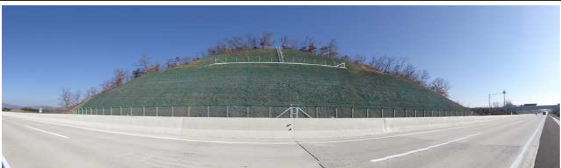
상주절토 56 (관리이정 74.962~75.098km / 8공구 STA.9+604~9+740)
