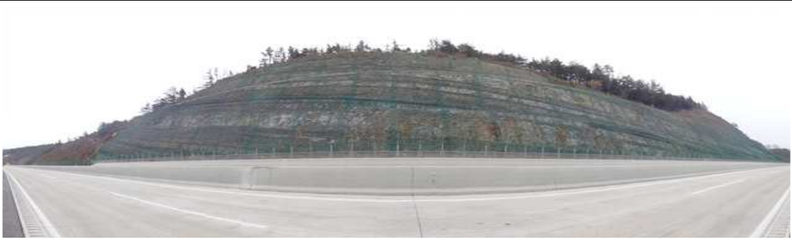
상주절토 9 (관리이정 14.494~14.934km / 2공구 STA.7+100~7+540)
