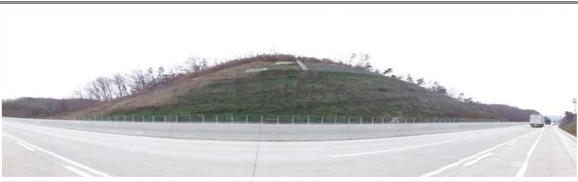
영천절토 54 (관리이정 74.338~74.518km / 8공구 STA.8+980~9+160)
