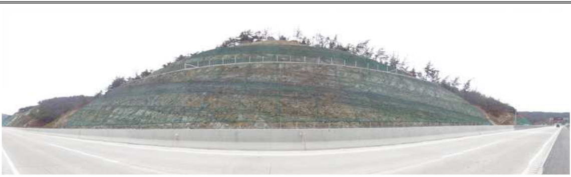
상주절토 30 (관리이정 38.525~38.685km / 5공구 STA.2+290~2+450)
