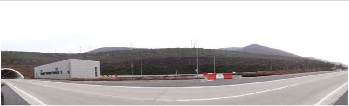
영천절토 17 (관리이정 21.614~22.054km / 3공구 STA.5+600~6+040)
