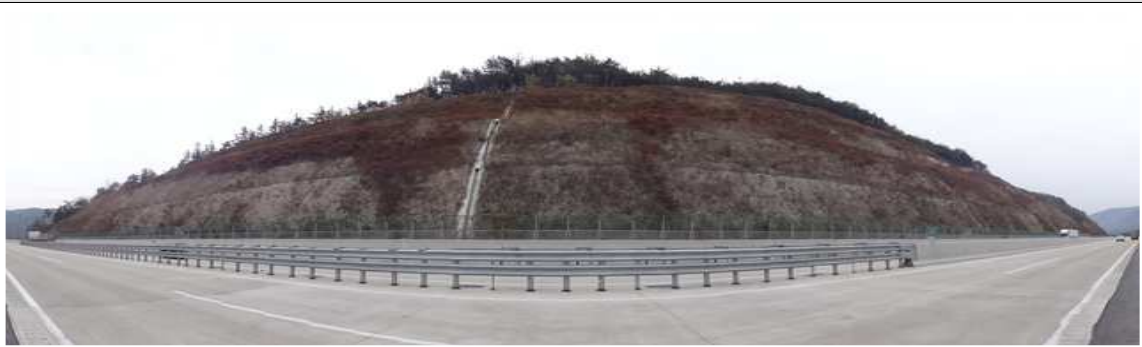
상주절토 13 (관리이정 16.864~17.284km / 3공구 STA.0+850~1+270)
