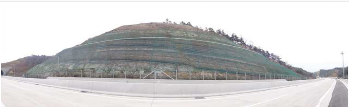
상주절토 10 (관리이정 15.314~15.514km / 2공구 STA.7+920~8+120)
