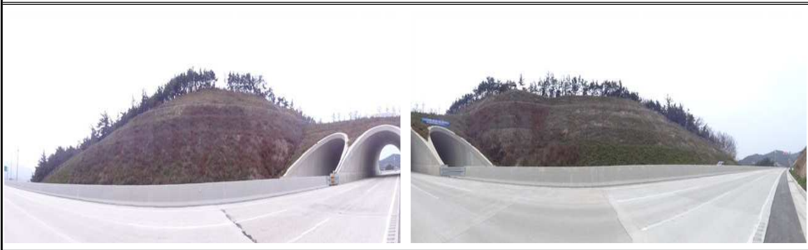
상주절토 2 (관리이정 2.240~2.510km / 1공구 STA.2+240~2+510)
