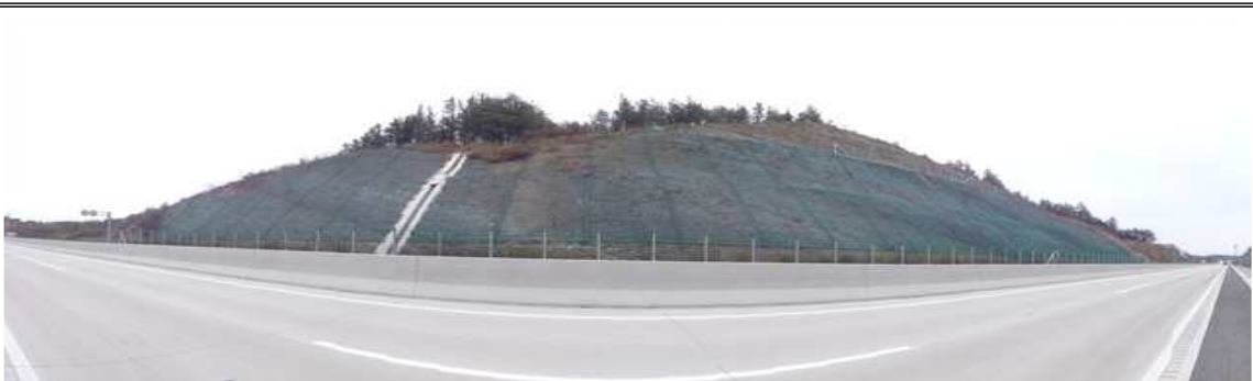
상주절토 44 (관리이정 66.378~66.678km / 8공구 STA.1+020~1+320)
