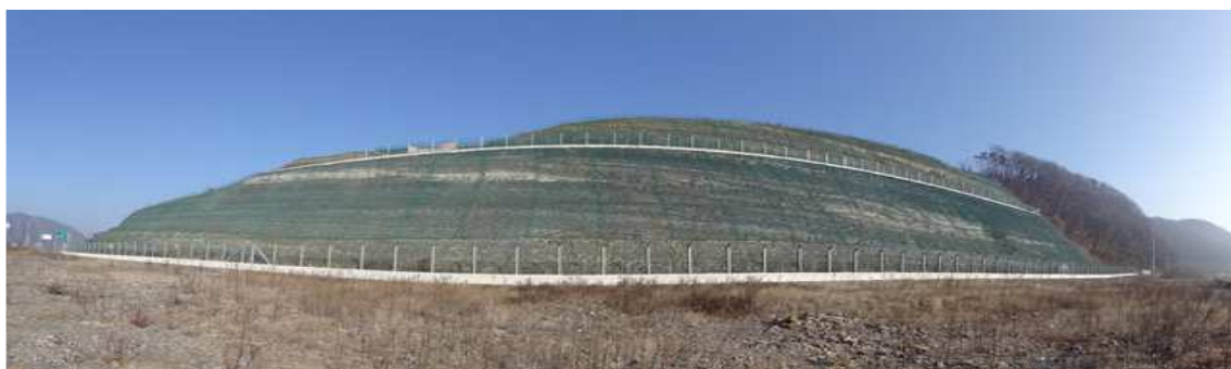
상주절토 35 (관리이정 0.160~0.42km / 6공구 STA.0+160~0+420(이설도로#2))
