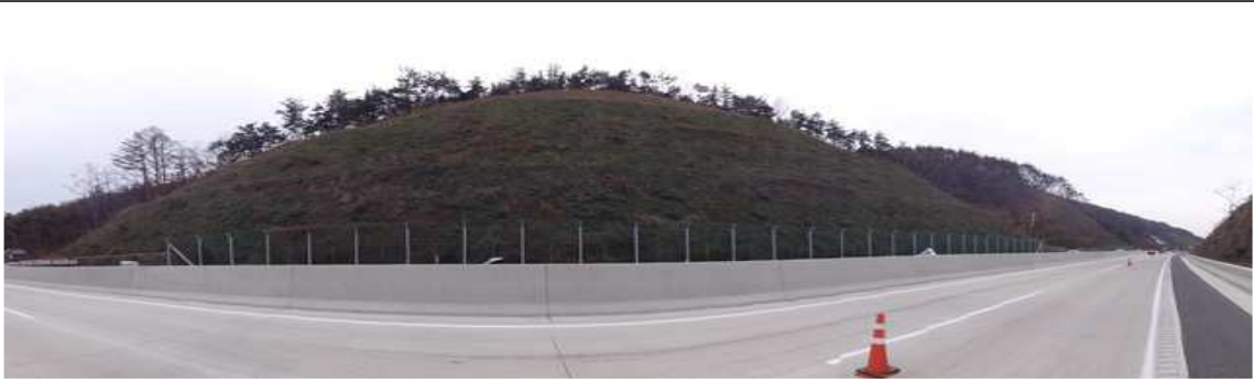
영천절토 39 (관리이정 55.188~55.448km / 6공구 STA.10+970~11+230)
