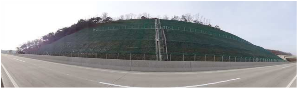
영천절토 58 (관리이정 0.920~1.340km / 8공구 화산JCT RA우측 STA.0+920~1+340)
