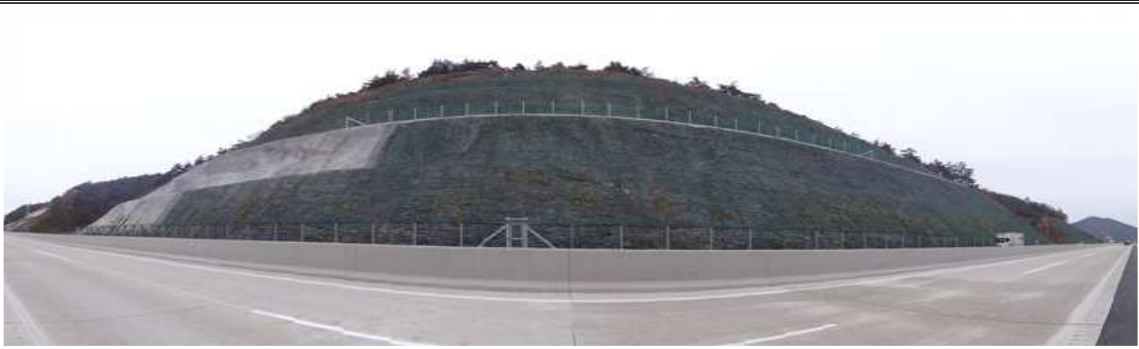
상주절토 43 (관리이정 58.858~59.078km / 7공구 STA.3+300~+3.520)
