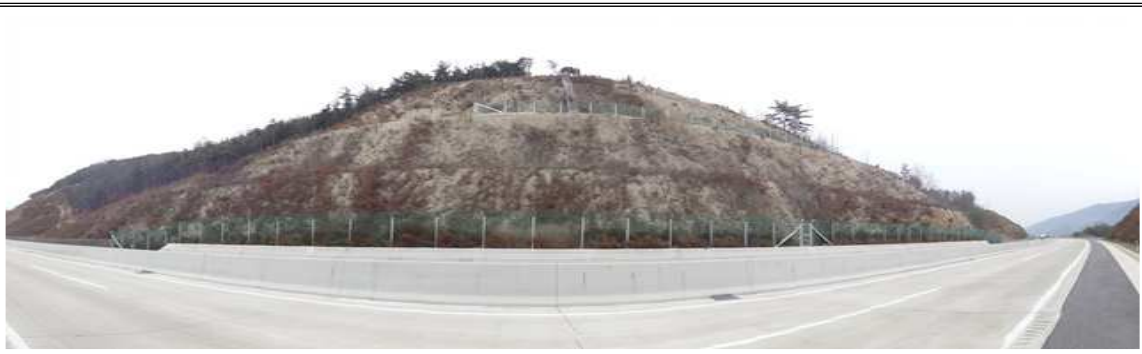
상주절토 14 (관리이정 17.304~17.504km / 3공구 STA.1+290~1+490)
