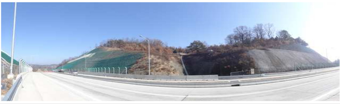
영천절토 59 (관리이정 1.600~1.723km / 8공구 화산JCT RA좌측 STA.1+600~1+723)
