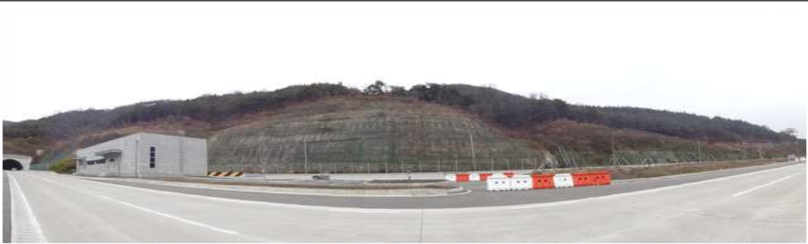
상주절토 27 (관리이정 36.235~36.375km / 5공구 STA.0+000~0+140)
