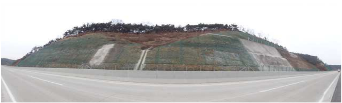
상주절토 29 (관리이정 38.165~38.455km / 5공구 STA.1+930~2+220)
