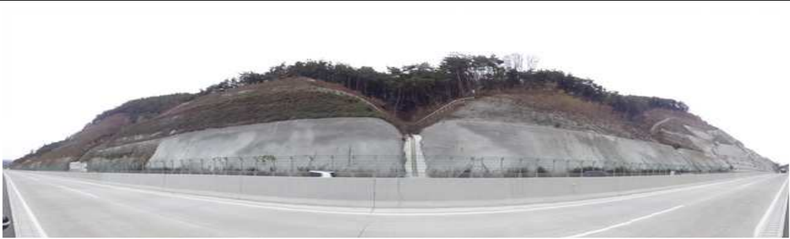
상주절토 37 (관리이정 54.038~54.798km / 6공구 STA.9+820~10+580)
