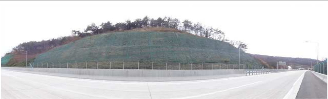
영천절토 31 (관리이정 40.025~40.175km / 5공구 STA.3+790~8+940)
