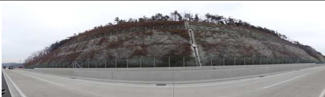
상주절토 36 (관리이정 53.068~53.448km / 6공구 STA.8+850~9+230)
