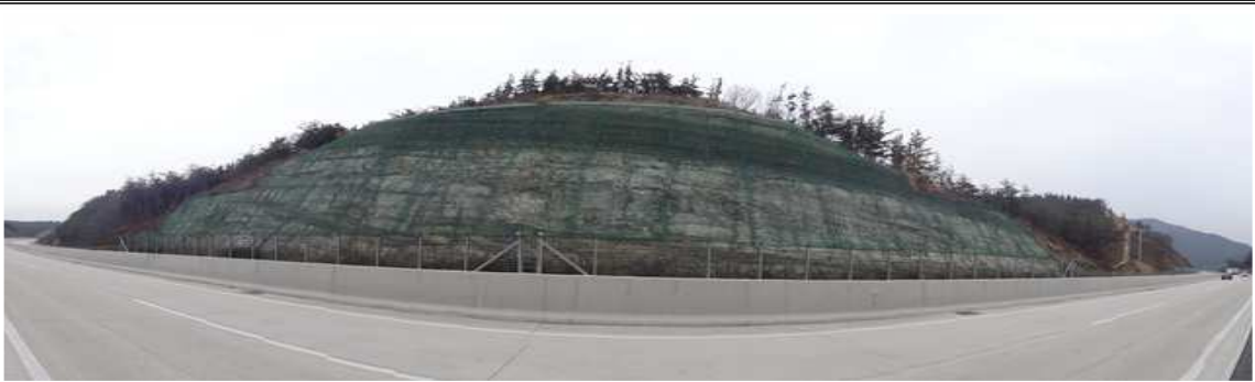
상주절토 11 (관리이정 15.894~16.014km / 2공구 STA.8+500~8+620)
