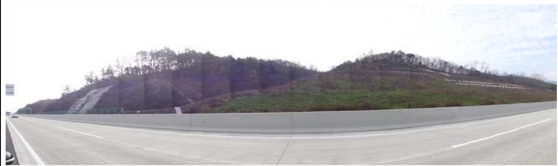
영천절토 21 (관리이정 26.654~27.034km / 3공구 STA.10+640~11+020)
