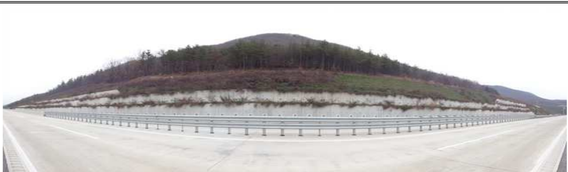
상주절토 16 (관리이정 21.194~22.054km / 3공구 STA.5+180~6+040)
